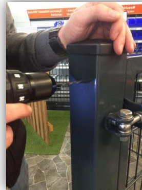
Vorbohren Ø4,5mm
